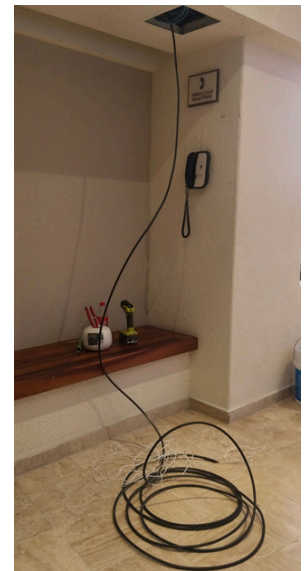
Instalación de Cableado Interior
