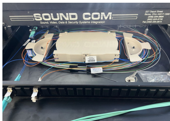
Terminación de Fibra Óptica
